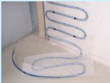
Heizmatte in einer Bahn von oben nach unten anbringen.
