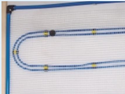
Heizmattengitter von oben nach unten auf grundierter Wand ausrollen.
